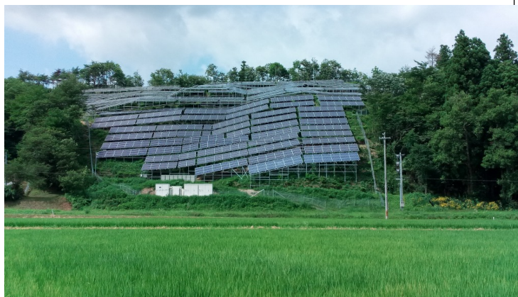
写真 無造作に設置されたソーラーパネル(一関市)
